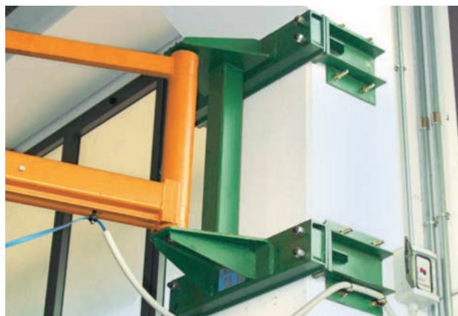
Imbragatura mediante tasselli chimici. Chemical bolts anchoring.
